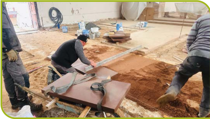
POSE DE NOUVELLES DALLES DANS LES ALLEES CENTRALES
