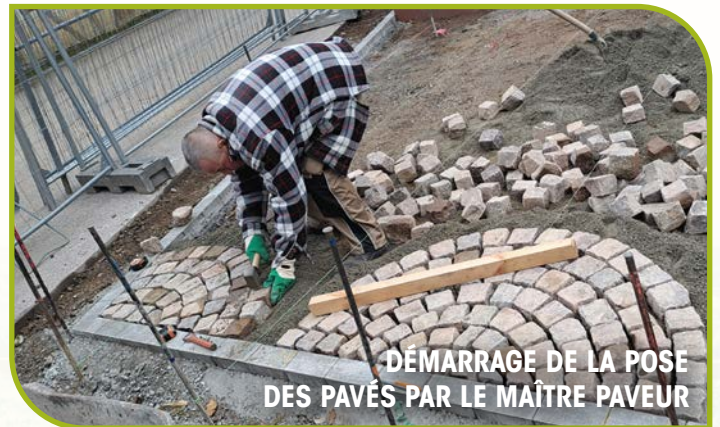
MISE EN PLACE DES BLOCS EN GRÈS
