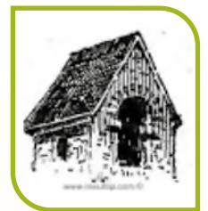
Toit en bâtière
