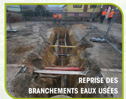
FOUILLE PAR CAMION ASPIRATEUR
