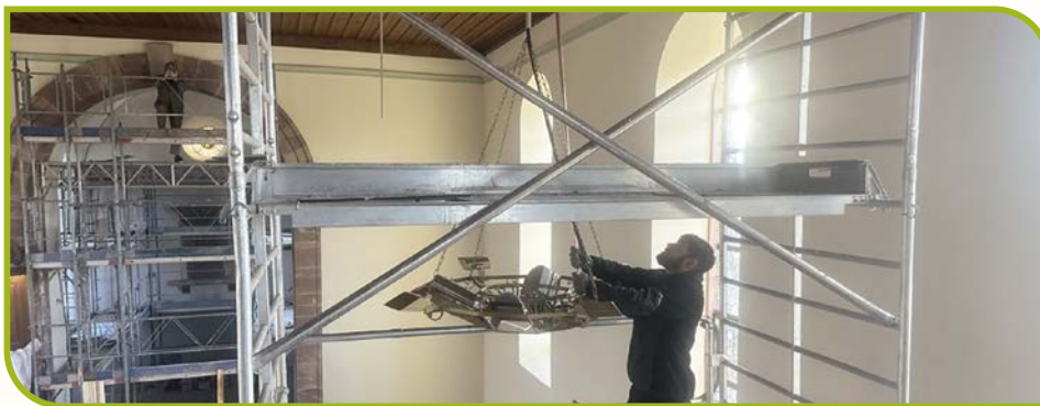
INSTALLATION DES LUSTRES RADIANTS DANS LA NEF
