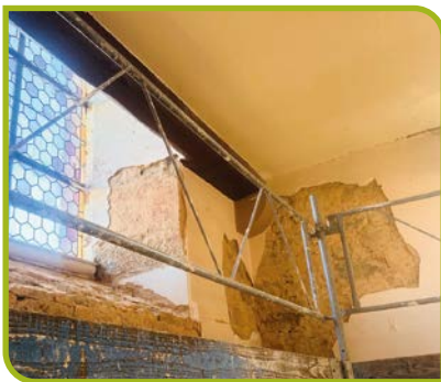
TRAVAUX DE PLATRERIE
