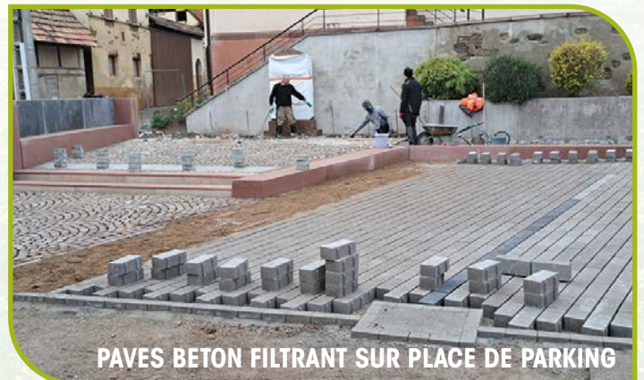
DÉMARRAGE DE LA POSE DES PAVÉS PAR LE MAÎTRE PAVEUR
