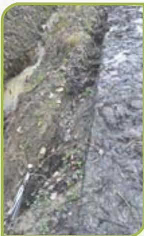
L'érosion régulière par les eaux de ruissellement, ainsi que le passage répété d'engins agricoles lourds sur le sol devenu instable, avaient aggravé la situation en dégradant le revêtement de la chaussée.
