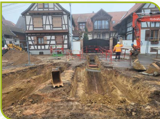
MISE EN ŒUVRE D'EAU POTABLE
