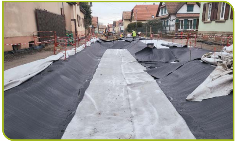
POSE DE GÉOMEMBRANE
