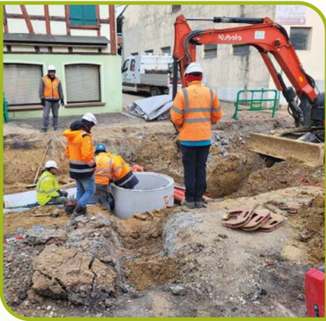
POSE DU DRAIN CENTRAL
