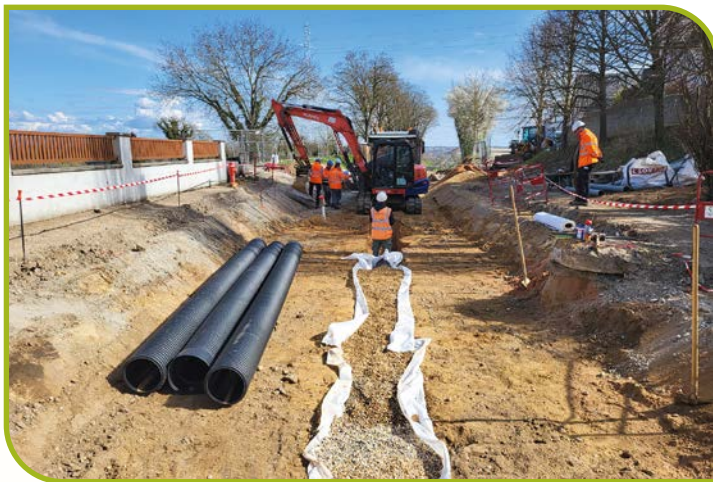
REPLISSAGE DES BASSINS / REMBLAI POREUX
