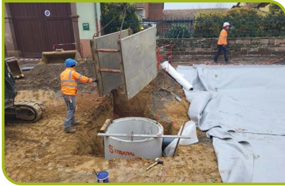
POSE D'UN REGARD DE VISITE
