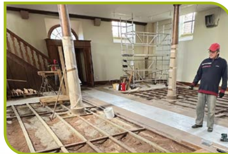
INSTALLATION DU PLANCHER BOIS – RESTAURATIONS DES BANCS ET REMISE EN PLACE
