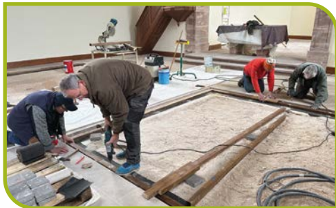
INSTALLATION DU PLANCHER BOIS – RESTAURATIONS DES BANCS ET REMISE EN PLACE
