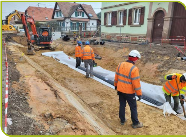
POSE DU DRAIN CENTRAL
