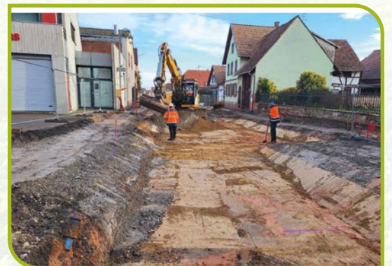
TERRASSEMENT DE BASSIN
