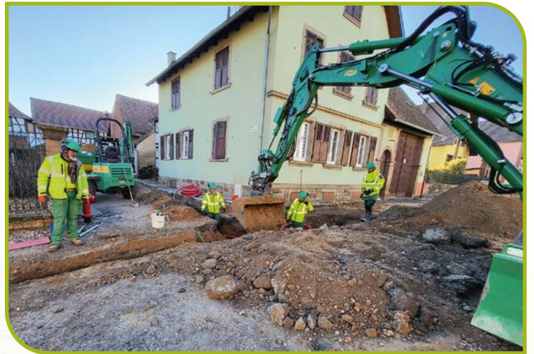
POSE RÉSEAU ÉCLAIRAGE PUBLIC
