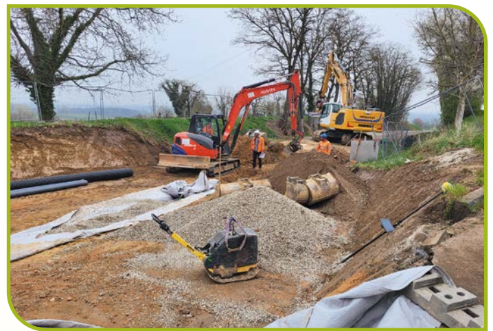
REPLISSAGE DES BASSINS / REMBLAI POREUX
