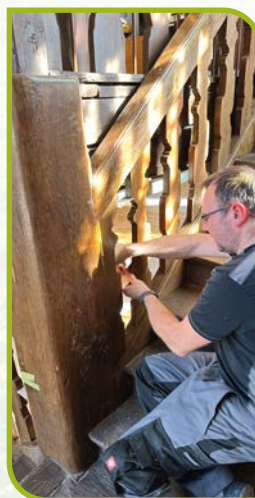
MISE AUX NORMES DU GARDE-CORPS ET INSTALLATION DE PORTIQUE SÉCURISANT
