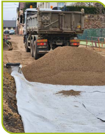
REPLISSAGE DES BASSINS / REMBLAI POREUX
