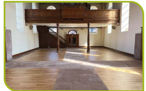
INSTALLATION DU PLANCHER BOIS – RESTAURATIONS DES BANCS ET REMISE EN PLACE
