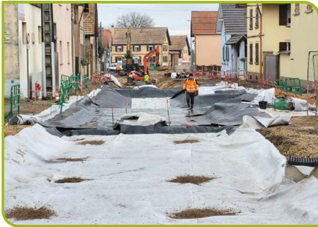
REPLISSAGE DES BASSINS / REMBLAI POREUX
