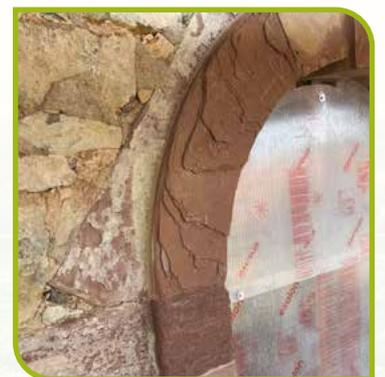
**RESTAURATION DES PIERRES DE TAILLE: LES PIERRES ABIMÉES ONT ÉTÉ REMPLACÉES SUR UNE PROFONDEUR DE 10 À 15 CM.**
